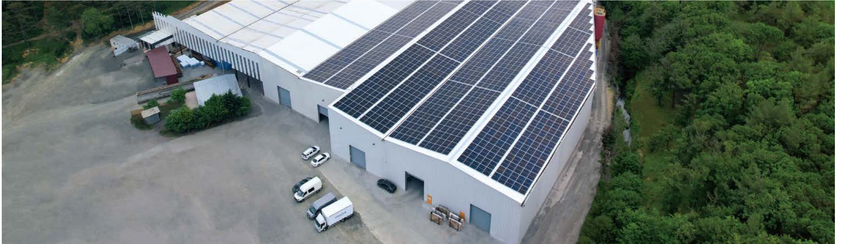
09 Energiekostensenkung für Mineralwasserfabrik in der Türkei, 900kW KSG-120CL-M0
